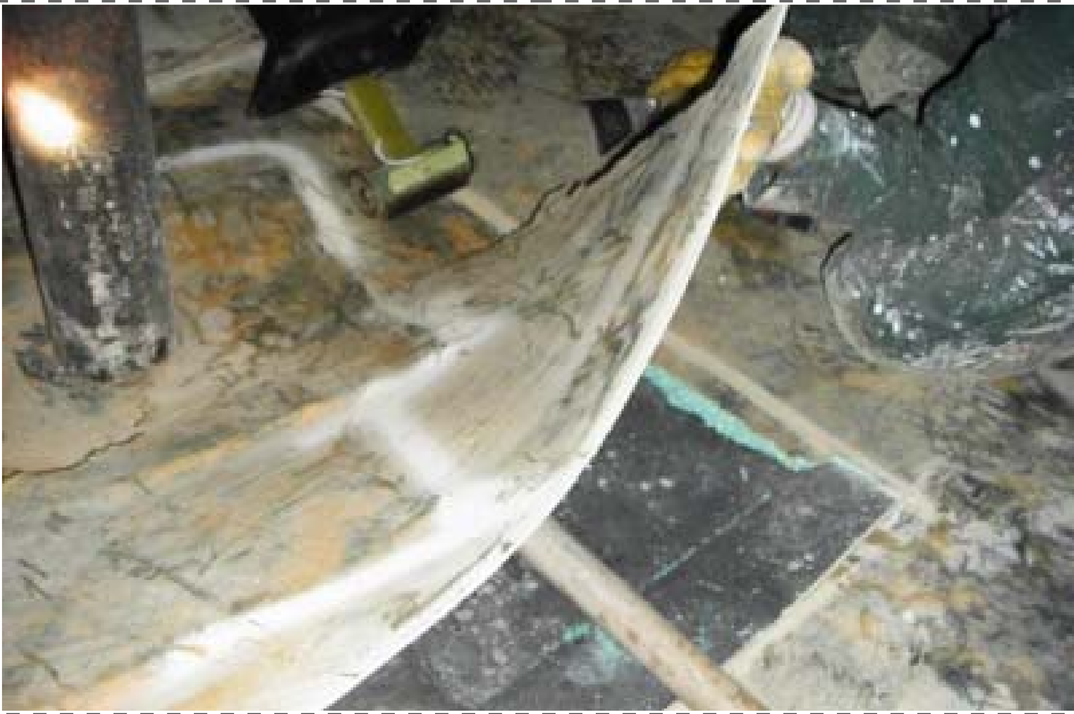
Glasfiberarmerad epoxi, 1,5-2 mm Kemikalietankbotten, Frankrike, Juni 2007
