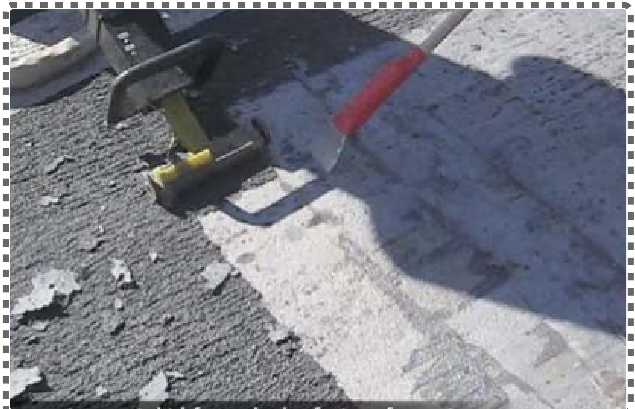
Friktionsbeläggning med karborundum, 2-3 mm Flygdäck, USS Nimitz, USA, Maj 2007
